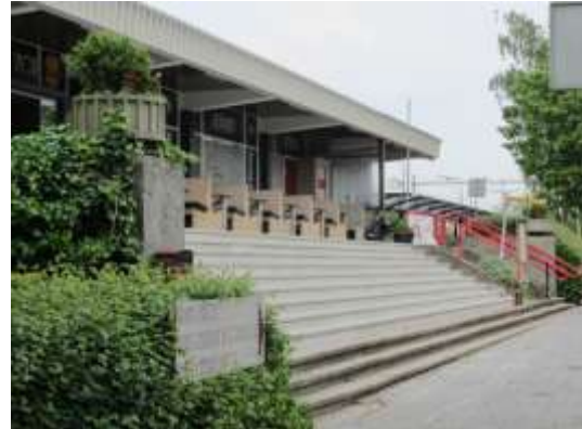
De gerenoveerde trappartij mag weer gezien worden.
