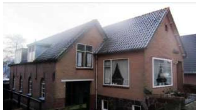
Links de oude hoepmakersschuur en rechts het nieuw gebouwde gedeelte van 'Orana'
